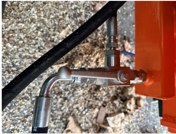
Fig. 9 Vanne du convoyeur
